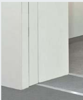
Nischenklappe bei geöffnetem Tor
